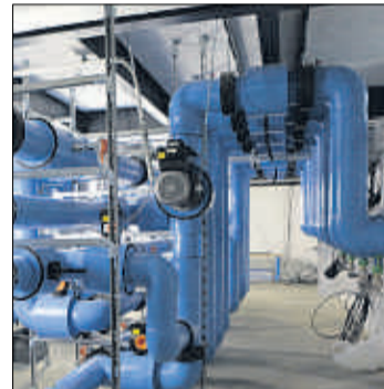
Im Untergeschoss der früheren Mondihallen wurde komplett neue Technik installiert.
